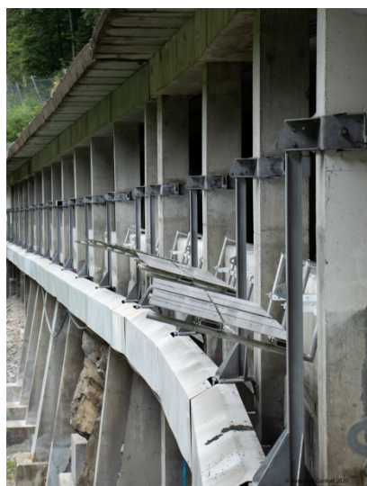
Réflecteurs côté Arcades Vue extérieure
